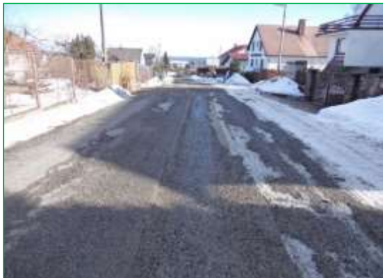
Cesta v Malém Drahlíně po vybudování přípojek
